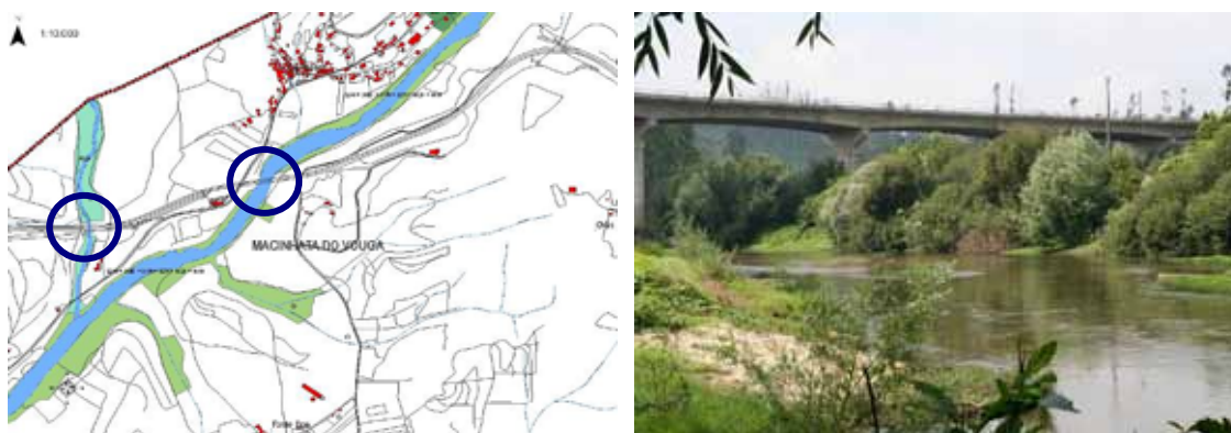
Figura 17 – Perspectivas do Sítio do Rio Vouga com o corte provocado pela A 25 (à esquerda), e pelo IC 2 (à direita).
